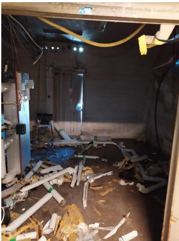
Figur 8: Nedriven rörisolering i rum 01 på källarplanet.
