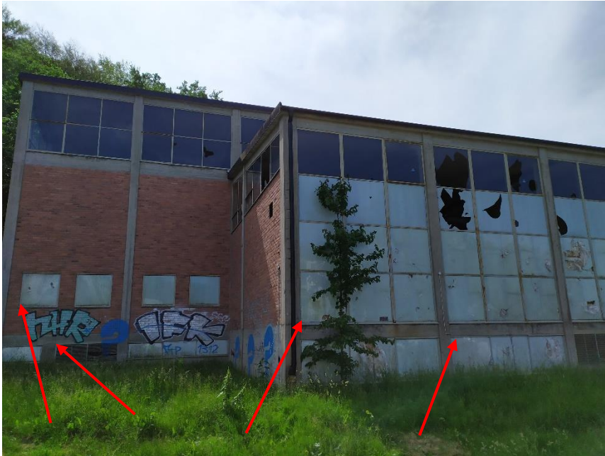
Figur 7: Fogar och tätningar runt fönster och luckor. Bildkälla: AFRY 2020-06-25.
