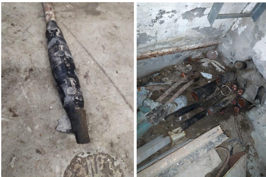
Figur 13: Misstänkt oljefyllda kablar i rum 05 på källarplan. Bildkälla: AFRY 2020-06-25.
