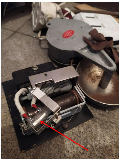
Figur 18: Relä med kvicksilverampull i rum 105. Bildkälla: AFRY 2020-06-25.
