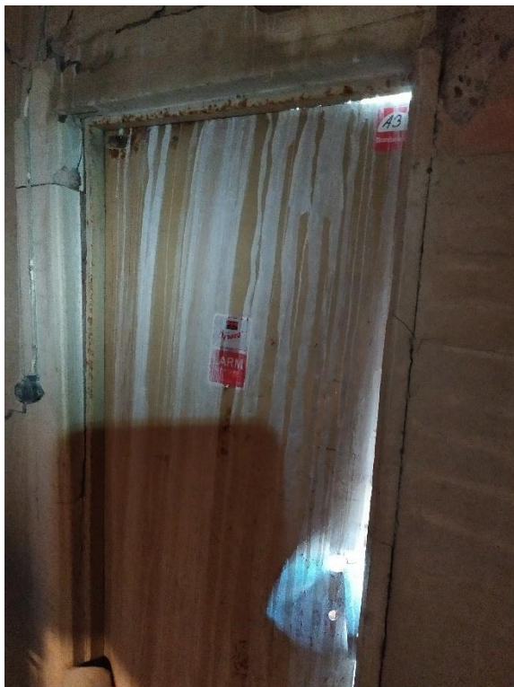
Figur 4: Branddörr med exponerad låskista i rum 01 på källarplanet. Bildkälla: AFRY 2020-06-25.
